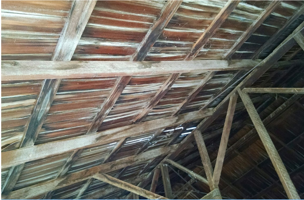
Barn interior (SWCA photo, 9/19/2018).
